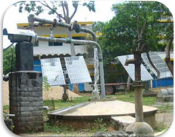
**Solarpumpensystem für Trinkwasser**
