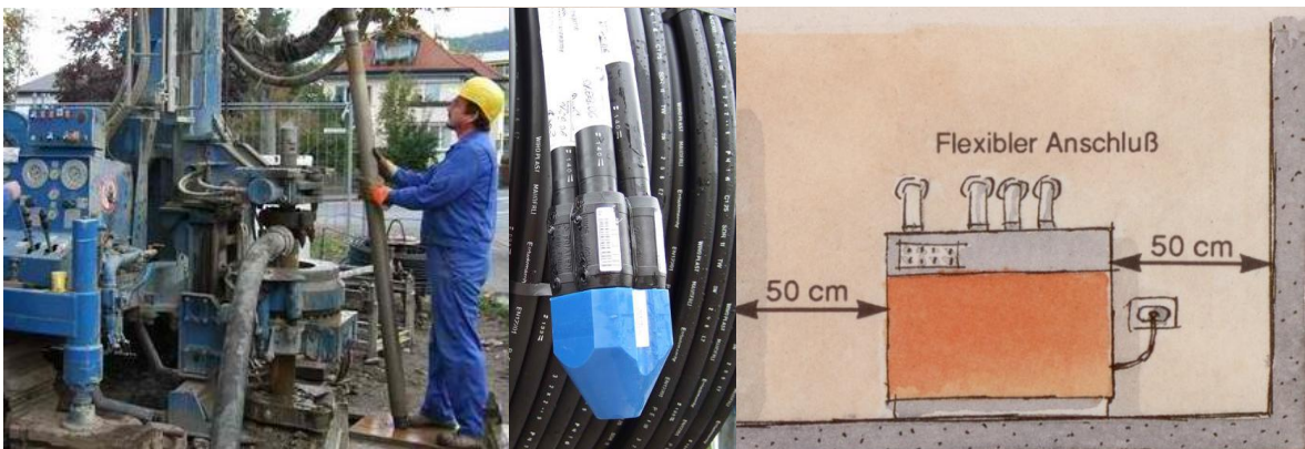
Wärme aus der Erde zu holen, mit der Erdsondentechnik. Flexibler Anschluss und Abstand
